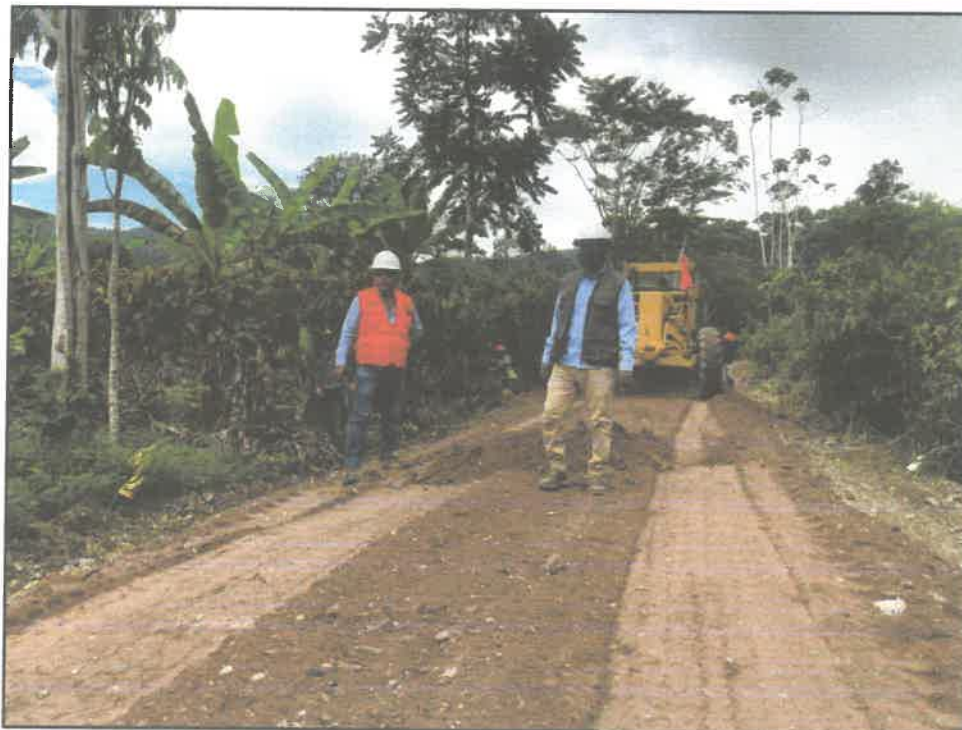
FOTOGRAFIA N° 05: Se puede apreciar en la imagen el uso correcto de los implementos de seguridad en obra.
