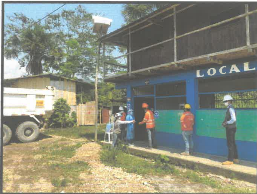
FOTOGRAFIA N° 02: Control de signos vitales (SatO2, F/C) del personal al ingreso y salida de la jornada laboral en el servicio de mantenimiento vial.
