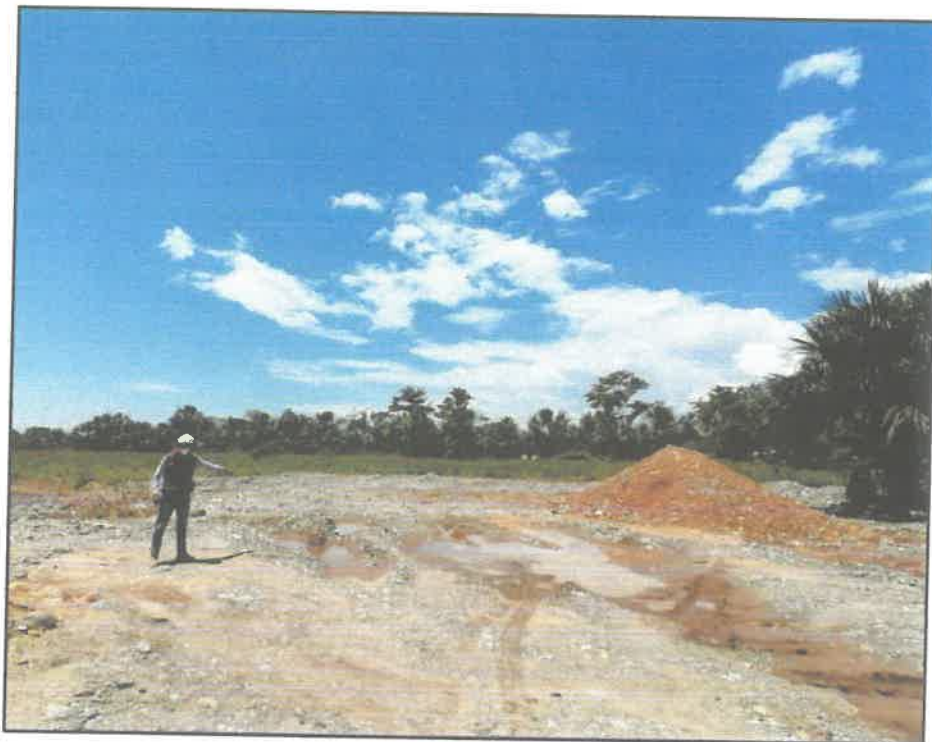
FOTOGRAFIA N° 02: Se puede apreciar en la imagen la recuperación de áreas ocupadas como centro de acopio, agrupando material seleccionado de afirmado para el mantenimiento rutinario.
