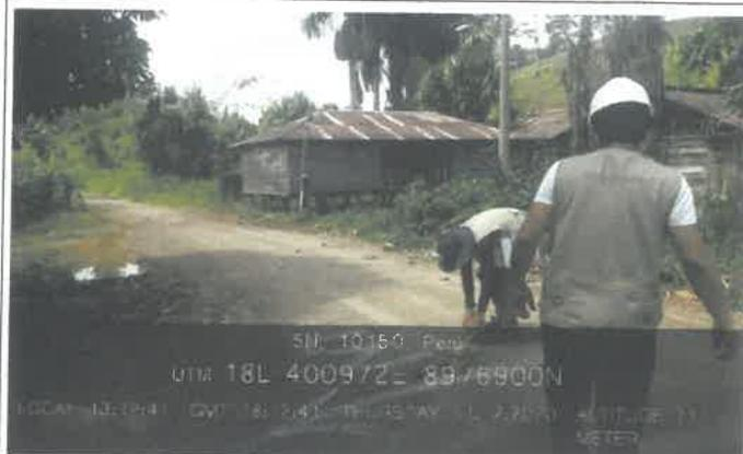
FOTO N°34. Trazo para ubicación de hito kilométrico en la progresiva 3+000 KM, sub tramo: Porvenir de Marona – Bajo Huayhuante.
