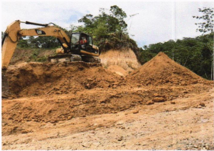
FOTO N° 03. TRAMO I: 5+500 KM la maquinaria excavadora realiza los trabajos en la cantera, coordenada (386939; 9000247) – dic 2020
