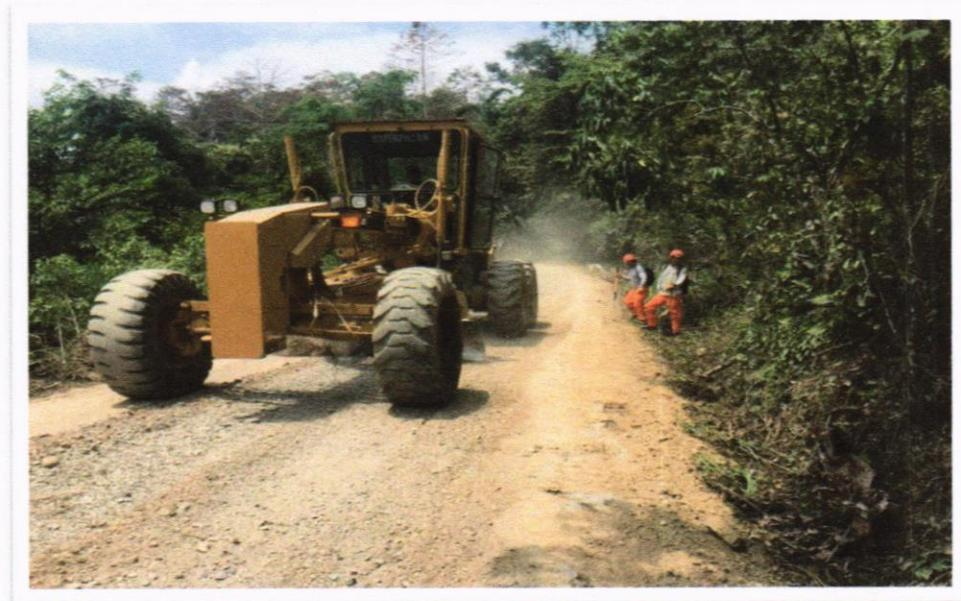
**FOTO 02:** En la imagen se observa los trabajos de nivelación y perfilación fecha 02/11/20 - zona 18 L – Coord. Este: 394559.083 m E - Coord. Norte 8971360.558 m S
