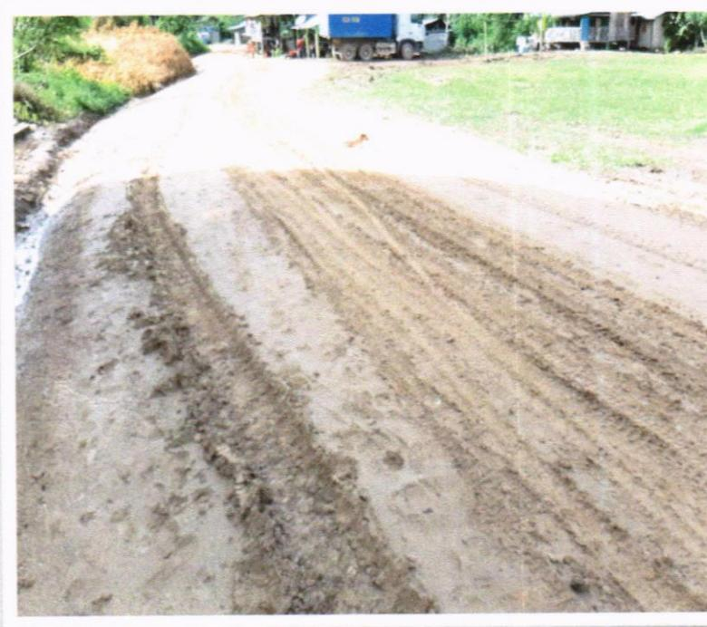
FOTO N° 08 En la imagen se observa que las lluvias provocaron deterioro del afirmado que se venía colocando pese hacer compactado - tramo Pampa Hermosa - Henrique Varela
