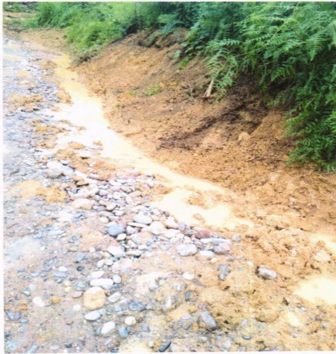
FOTO N° 05 En la imagen se observa las inundaciones y deformaciones de cunetas consecuencias de las lluvias - tramo Pampa Hermosa
