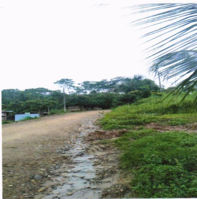
FOTO N° 06 En la imagen se observa que las lluvias provocaron inundaciones y acumulación de tierra en las cunetas - tramo Pampa Hermosa
