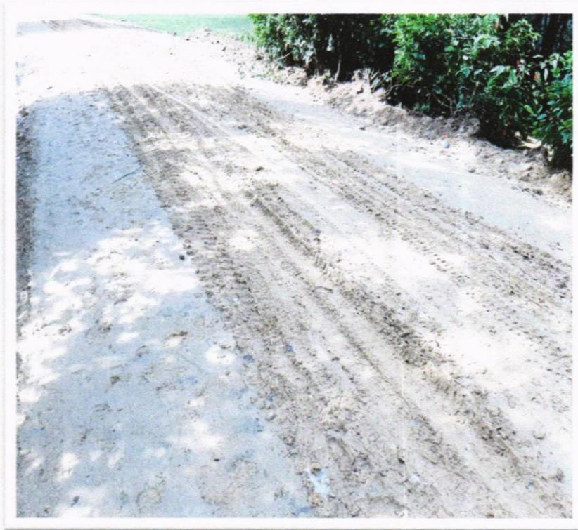
FOTO N° 09 En la imagen se observa que las lluvias provocaron deterioro del afirmado que se venía colocando pese hacer compactado - tramo Pampa Hermosa - Henrique Varela
