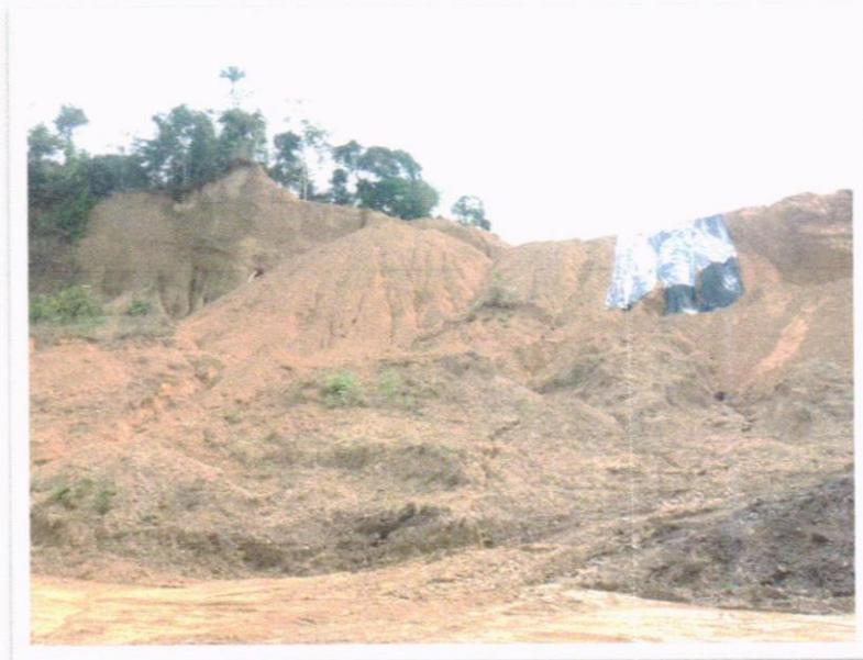
FOTO N° 12 En la imagen se observa que pese a que se protege el material en la cantera deja húmedas y no se puede moverlos porque se saturan y se tiene que esperar varios días a que seque siempre que no vuelva llover Progresiva 5+ 495 - Pampa Hermosa
