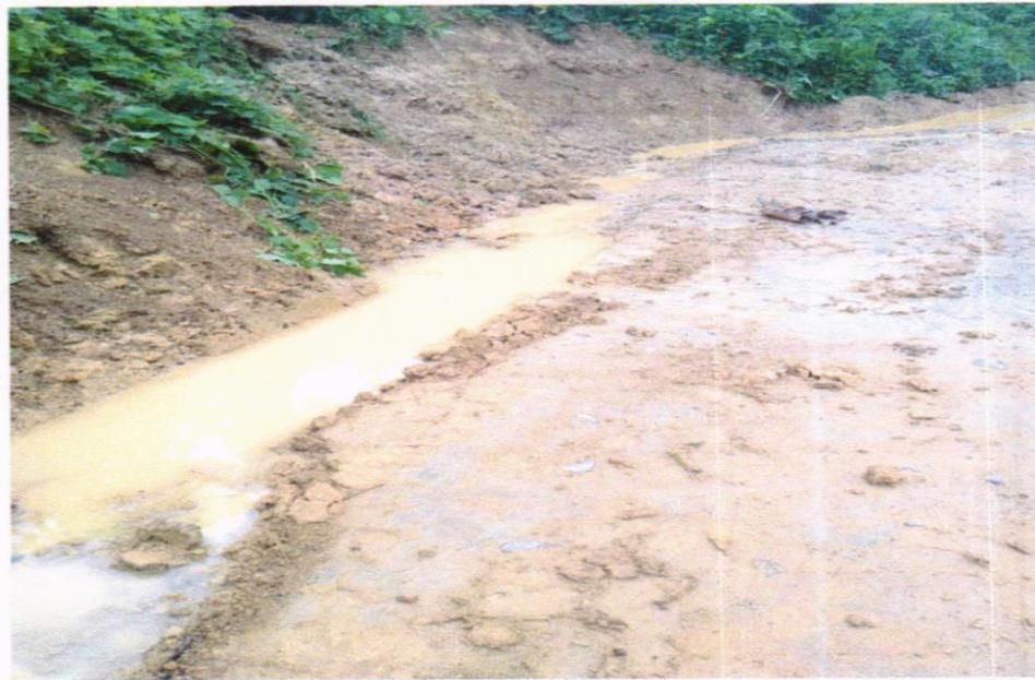
FOTO N° 04 En la imagen se observa las inundaciones y deslizamiento de tierras a consecuencias de las lluvias - tramo Pampa Hermosa
