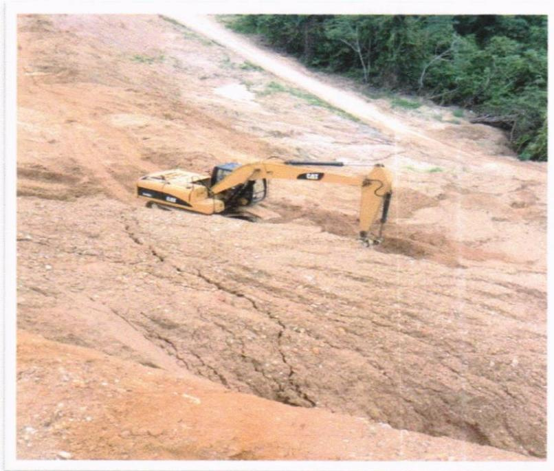
FOTO N° 10 En la imagen se observa que las lluvias saturaron el material acumulado en cantera y que todo el acceso quedaron intransitables Progresiva 5+495 - Pampa Hermosa
