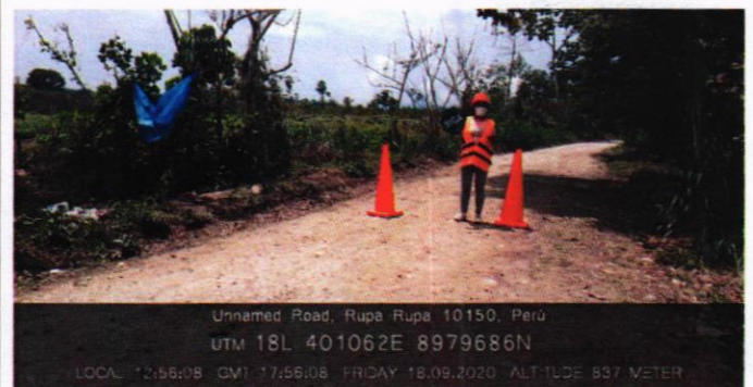
FOTO N°44. Paletera de tránsito ubicada en el sub tramo II: Porvenir de Marona - Alto Marona en la Progresiva 0+000 Km.
