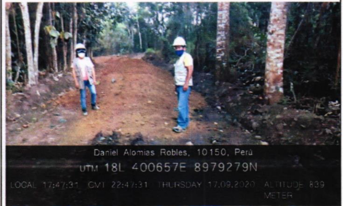
FOTO N°42. material granular descargado para capa nivelante de 5 cm. en el sub tramo III: Porvenir de Marona - Bajo Huayhuante en la progresiva 3+030 Km.
