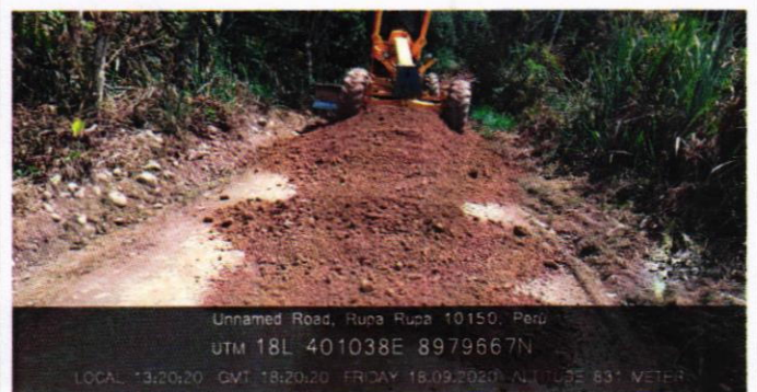
FOTO N°36. conformación de material granular en el sub tramo II: Porvenir de Marona - Alto Marona en la Progresiva 0+025 Km.
