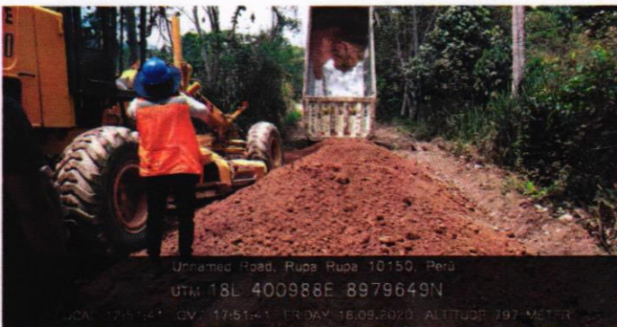
FOTO N°37. Descarga de material afirmado en el sub tramo II: Porvenir de Marona - Alto Marona en la Progresiva 0+080 Km.
