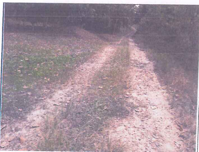
Foto 10. Tramo 01+000 al 02+000, presenta Topografía Accidentado, con un ancho de superficie promedio de 3.50 m.
