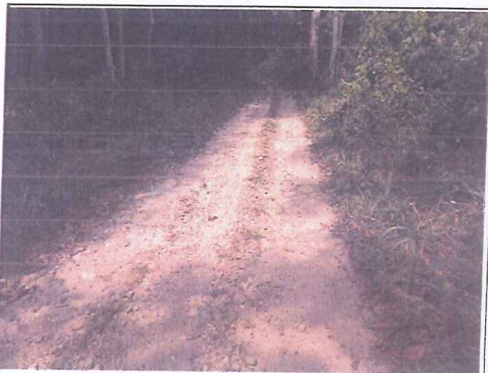
Foto 09. Tramo 00+000 al 01+000, presenta Topografía Ondulado, con un ancho de superficie promedio de 3.20 m.
