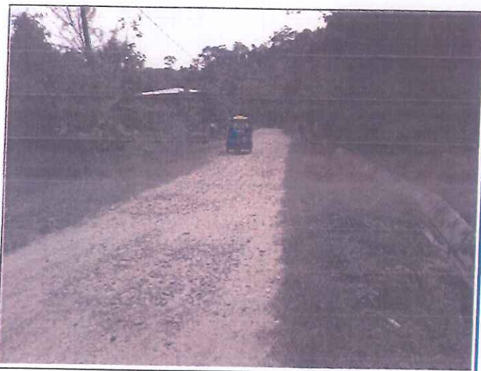
Foto 02. Tramo 00+228 al 01+000, presenta una Topografía Plana, con un ancho de superficie promedio de 3.50 m.
