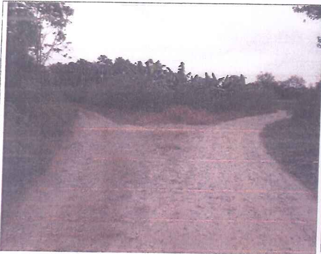
FOTO N° 01: Se muestra el Desvio hacia abajo Huayhuante en la Prog. 0+308.00 sin señales.
