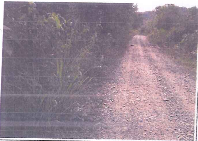
Foto 09. Tramo 03+000 al 04+000, presenta Topografía Accidentado, con un ancho de superficie promedio de 3.20 m.
