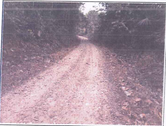
Foto 07. Tramo 02+000 al 03+000, presenta Topografía Ondulado, con un ancho de superficie promedio de 3.50 m.
