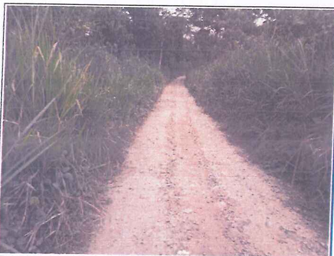
Foto 06. Tramo 00+000 al 01+000, presenta Topografía Plana, con un ancho de superficie promedio de 3.30 m.
