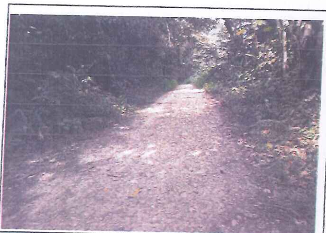
Foto 05. Tramo 01+000 al 02+000, presenta Topografía Ondulada, con un ancho de superficie promedio de 3.60 m.
