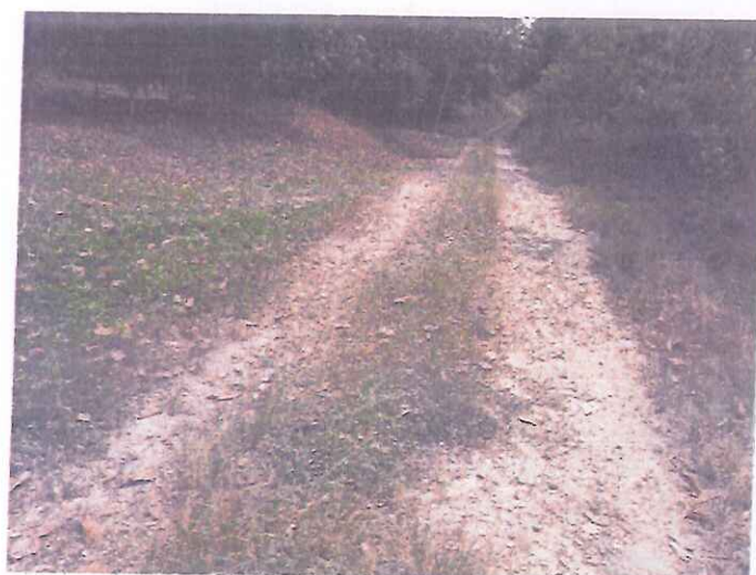
FOTO N°06. Se puede apreciar el estado de la superficie de rodadura entre el km 00+000 – km 01+000 del Sub Tramo III
