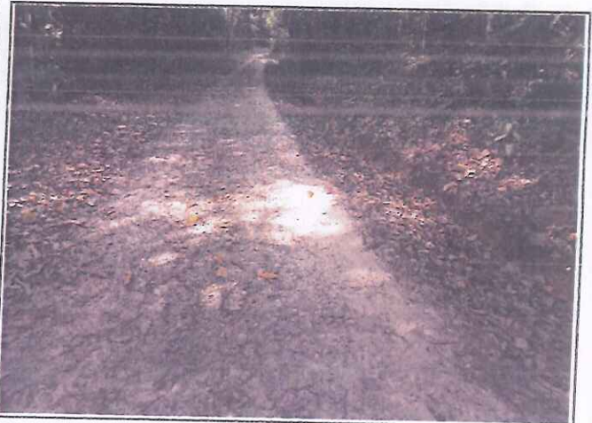
Foto 26. Tramo 00+000 al 01+000, presenta erosión de Nivel de gravedad 2 en la Plataforma.
