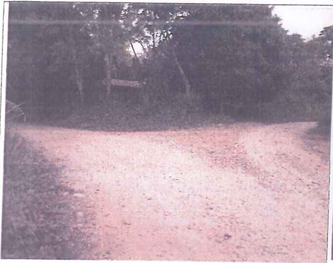
FOTO N° 01: En esta toma se muestra el Ingreso al tramo II: (PORVENIR DE MARONA) - ALTO MARONA sin señal Informativa.
