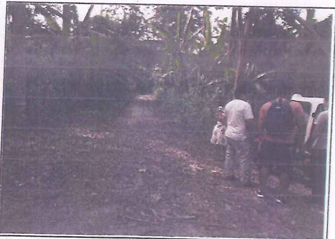
Foto 12. Prog. 04+858.00, Fin de Tramo llegada a la localidad de Huamancoto.
