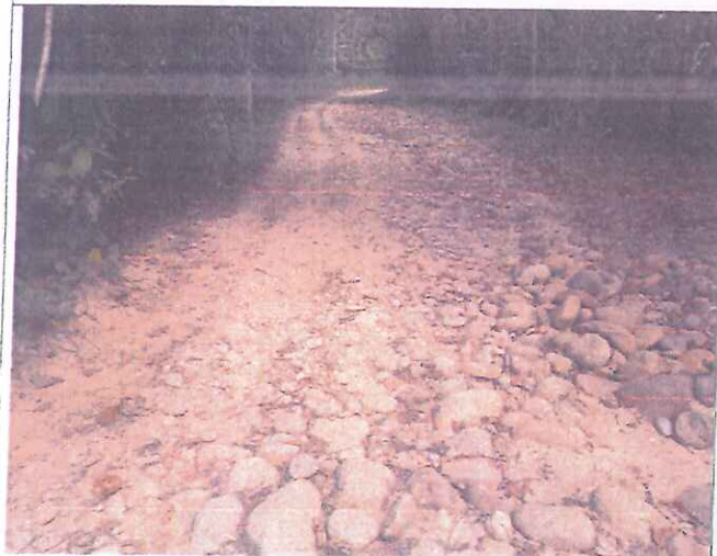
FOTO N° 03: En esta tambien se Observa que no existe señales de prevencion.
