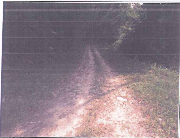
Foto 11. Tramo 02+000 al 03+013, presenta Topografía Ondulada, con un ancho de superficie promedio de 3.30 m.
