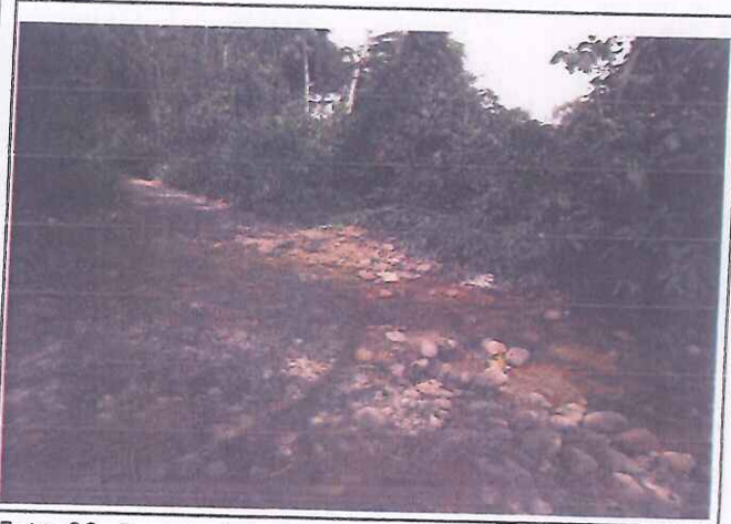
Foto 06. En esta toma se muestra en la Prog. 1+896.00 canal de Pase de Agua y Fuente de Agua N°01
