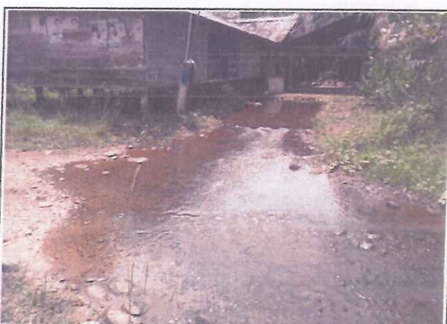
Foto 34. Prog. 03+013.00, Fin de Tramo llegada a la localidad de Bajo Huayhuante.
