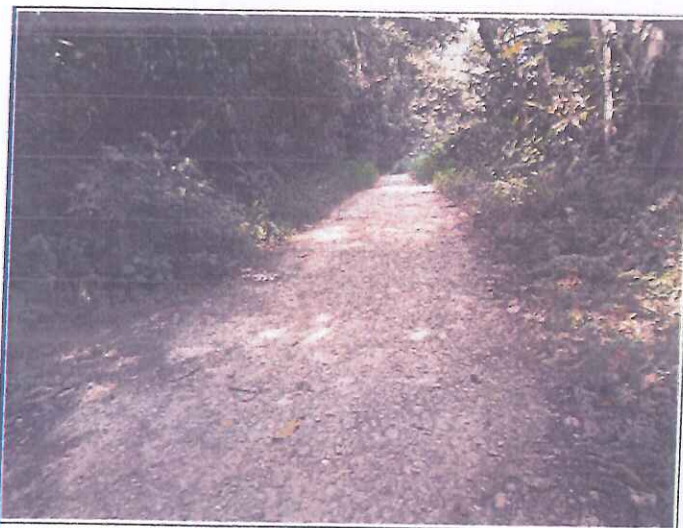
Foto 04. Tramo 02+000 al 03+000, presenta Topografía Ondulado, con un ancho de superficie promedio de 3.30 m.
