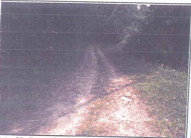
Foto 29. Tramo 02+000 al 03+013, presenta Topografía Ondulada, con un ancho de superficie promedio de 3.30 m.
