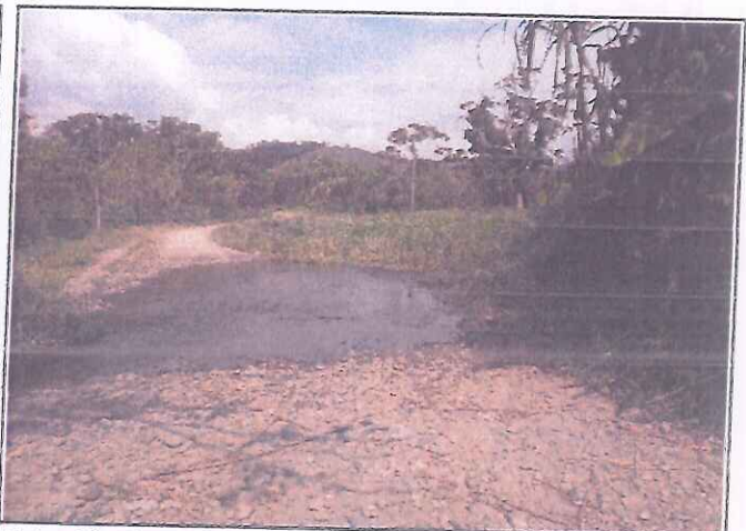
Foto 10. En esta toma se muestra en la Prog. 3+752.00 canal de Pase de Agua y Fuente de Agua N°02.
