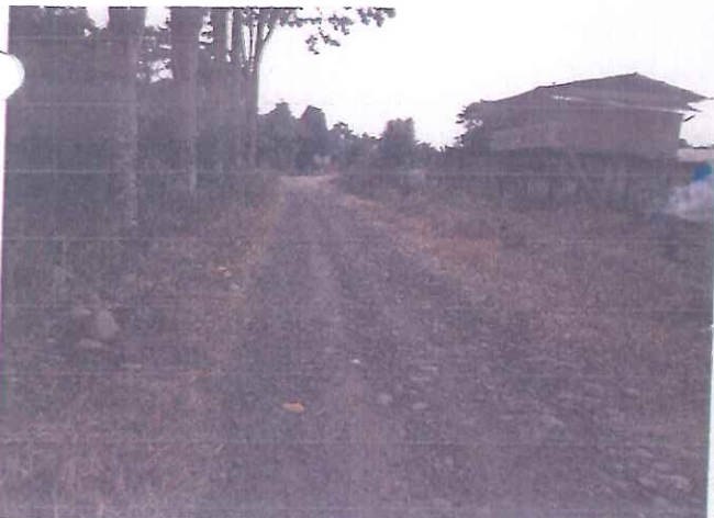
Foto 23. Tramo 03+000 al 04+000, presenta Topografía Accidentado, con un ancho de superficie promedio de 3.30 m.
