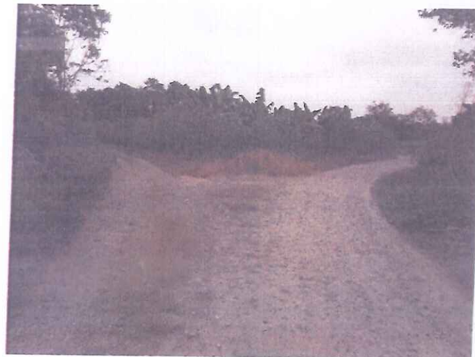
FOTO N°04. Se puede apreciar el estado de la superficie de rodadura entre el km 00+000 – km 03+000 del Sub Tramo II
