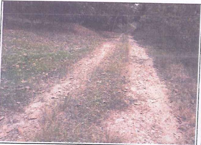
Foto 27. Tramo 01+000 al 02+000, presenta Topografía Accidentada, con un ancho de superficie promedio de 3.50 m.
