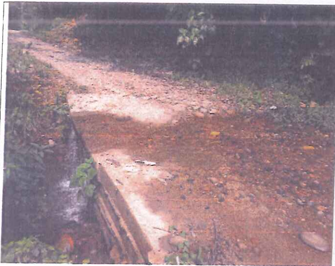
FOTO N° 01: En esta toma se Observa un Baden concreto Parcialmente Obstruido. En la Prog. 1+804.00.
