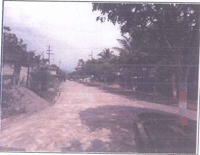
Foto 01. En esta toma se muestra el Ingreso al tramo Emp. EMP PE-5N (PUMAHUASI) - HUAMANCOTO .
