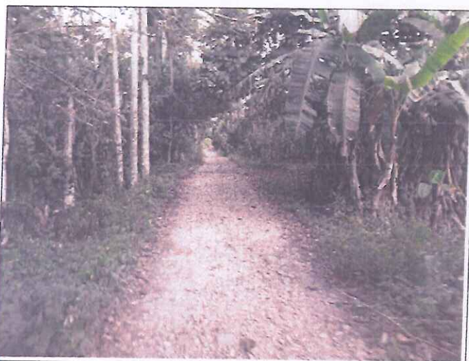
Foto 05 Tramo 04+000 al 04+858, presenta Topografía Ondulado, con un ancho de superficie promedio de 3.00 m.
