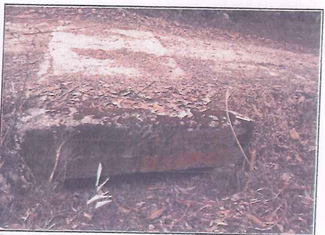
Foto 18. En esta toma se puede apreciar el Ponton de L= 2.50 en la Prog. 1+200.00 totalmente Obstruido.
