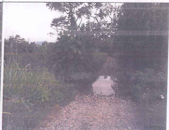
FOTO N° 04: en esta toma se puede observar pase de agua por la plataforma ocasionando daños.
