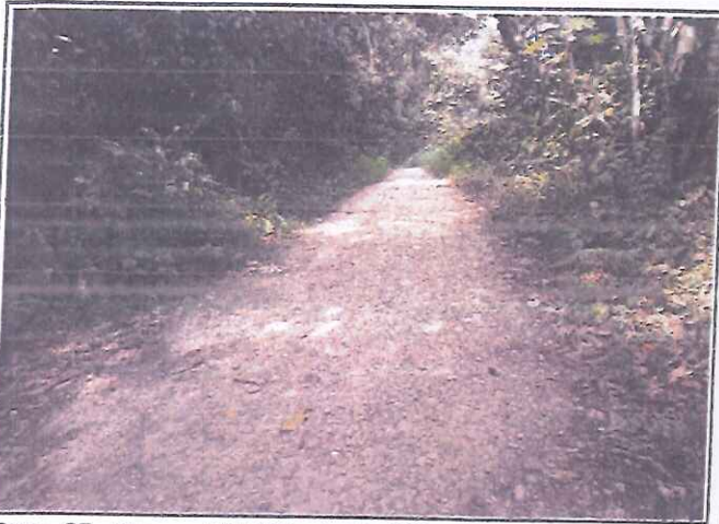
Foto 07. Tramo 02+000 al 03+000, presenta Topografía Ondulado, con un ancho de superficie promedio de 3.30 m.
