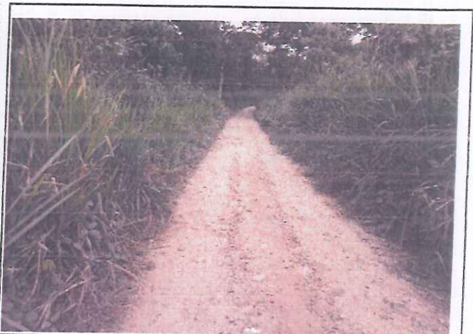
Foto 14. Tramo 00+000 al 01+000, presenta Topografía Plana, con un ancho de superficie promedio de 3.30 m.
