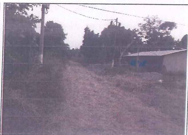
Foto 24. Tramo 04+000 al 04+326, presenta Topografía Ondulado, con un ancho de superficie promedio de 3.00 m.
