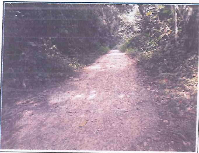
Foto 03. Tramo 01+000 al 02+000, presenta Topografía Ondulada, con un ancho de superficie promedio de 3.60 m.
