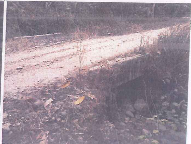
FOTO N° 04: en esta toma se puede observar un ponton en estado regular.
