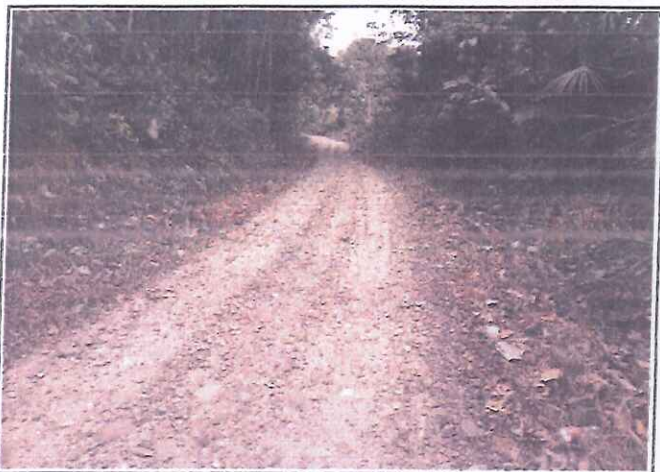
Foto 19. Tramo 02+000 al 03+000, presenta Topografía Ondulado, con un ancho de superficie promedio de 3.50 m.
