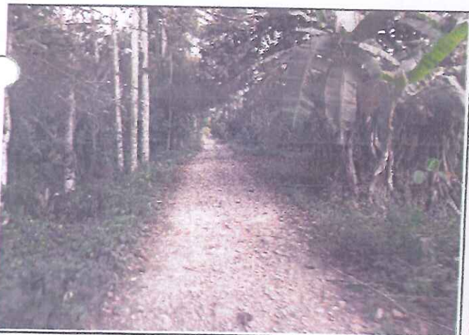
Foto 11 Tramo 04+000 al 04+858, presenta Topografía Ondulado, con un ancho de superficie promedio de 3.00 m.
