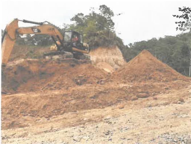
FOTO N°11. TRAMO I: 5+500 KM acopio de material afirmante, coordenada (386939; 9000247) – 30/10/2020.
