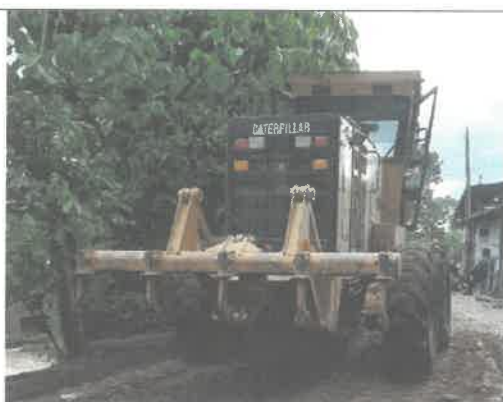
FOTO N°19. TRAMO I: 9+360 KM corte de plataforma e=0.20m, coordenada (389284; 9001568) – 26/10/2020.
