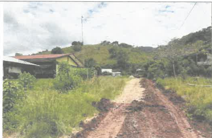
FOTO N°18. TRAMO II: 3+700 KM corte de plataforma e=0.20m, coordenada (385557; 9003520) – 27/10/2020.
