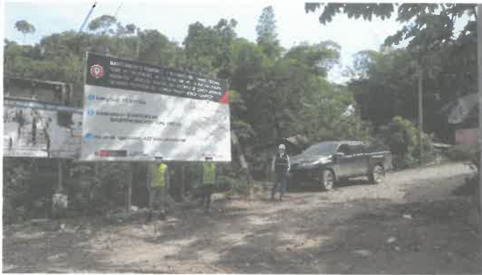
FOTO N°01. TRAMO I: 0+000 KM, Cartel de obra, coordenada (383031; 9002244) – 31/10/2020
