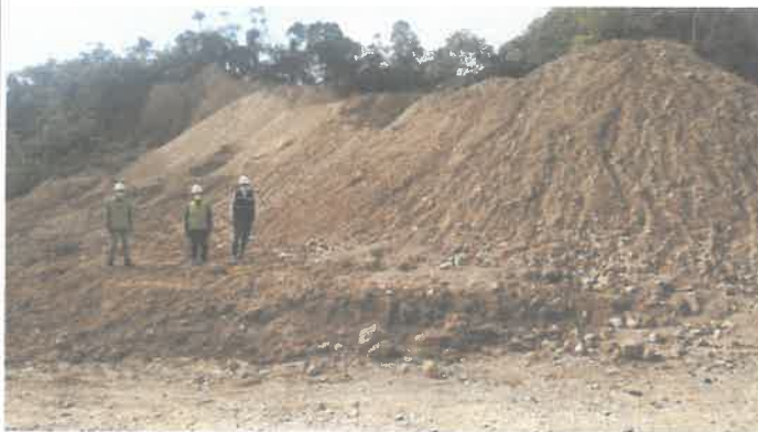
FOTO N°03. TRAMO I: 5+580 KM, acopio de afirmado, coordenada (386982; 9000227) – 31/10/2020
