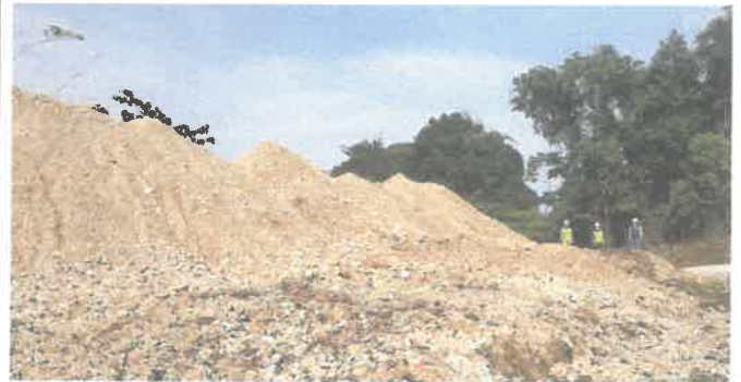
FOTO N°04. TRAMO I: 5+580 KM, acopio de afirmado, coordenada (386982; 9000227) – 31/10/2020
