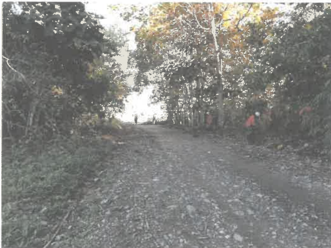
FOTO N°25. TRAMO I: 6+670 KM limpieza de terreno, coordenada (387893; 9000448) – 23/10/2020.
