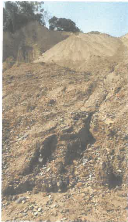
FOTO N°05. TRAMO I: 5+580 KM, acopio de afirmado, coordenada (386982; 9000227) – 31/10/2020
