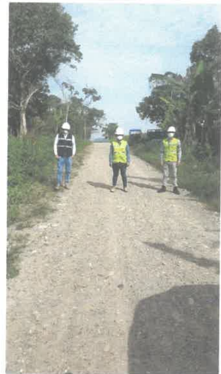
FOTO N°06. TRAMO I: 6+060 KM, capa nivelante, coordenada (387450; 9000206) – 31/10/2020
