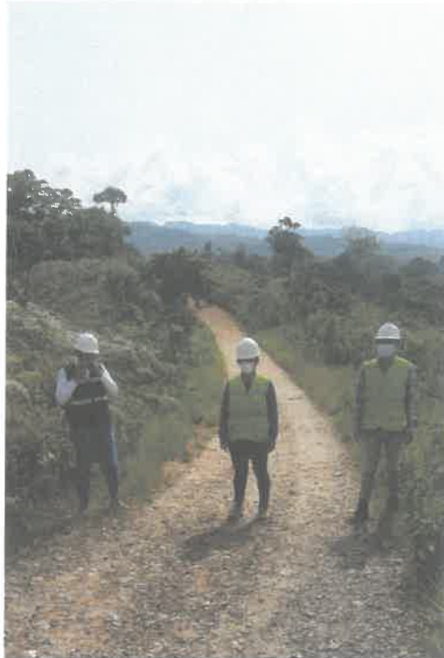
FOTO N°09. TRAMO II: 2+500 KM capa nivelante, coordenada (384549; 9003191) – 31/10/2020
