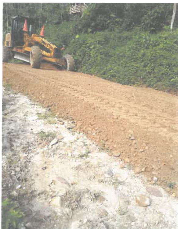
FOTO N°15. TRAMO I: 9+560 KM colocación de afirmado, coordenada (389226; 9001764) – 29/10/2020.
