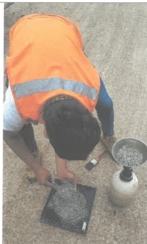
FOTO N°14. TRAMO I: 9+591 KM prueba de densidad de campo, coordenada (389228; 9001790) – 30/10/2020.
