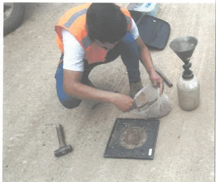
FOTO N°12. TRAMO I: 9+591 KM prueba de densidad de campo, coordenada (389228; 9001790) – 30/10/2020.
