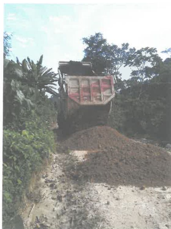
FOTO N°16. TRAMO I: 9+450 KM descarga de material, coordenada (389257; 9001652) – 28/10/2020
