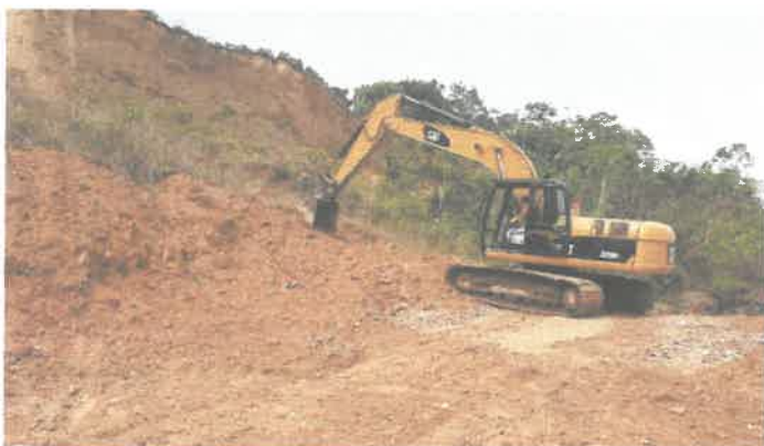
FOTO N°17. TRAMO I: 5+500 KM acopio de material afirmante, coordenada (386939; 9000247) – 27/10/2020.
