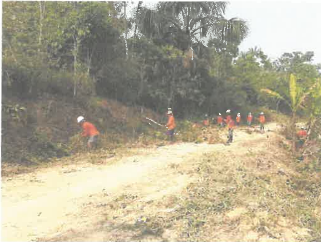
FOTO N°23. TRAMO I: 2+960 KM limpieza de terreno, coordenada (385350; 9000812) – 23/10/2020.
