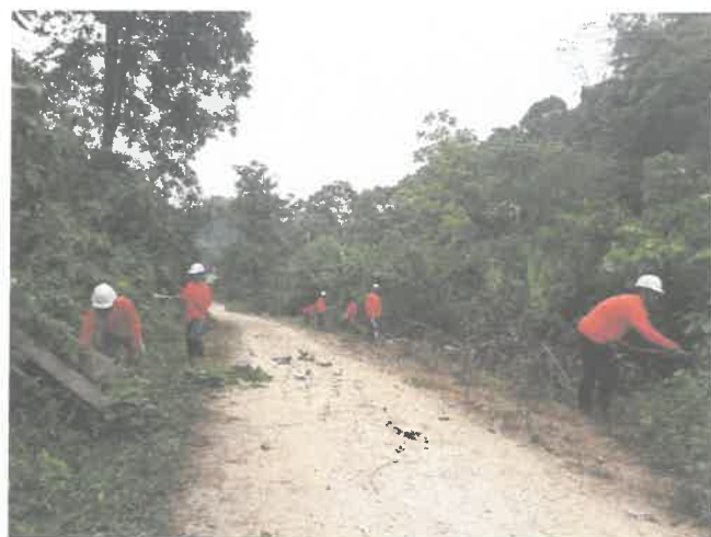
FOTO N°22. TRAMO I: 1+680 KM limpieza de terreno, coordenada (384471; 9001676) – 24/10/2020.
