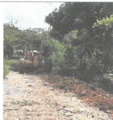
FOTO N°20. TRAMO I: 9+240 KM corte de plataforma e=0.20m, coordenada (389286; 9001448) – 26/10/2020.
