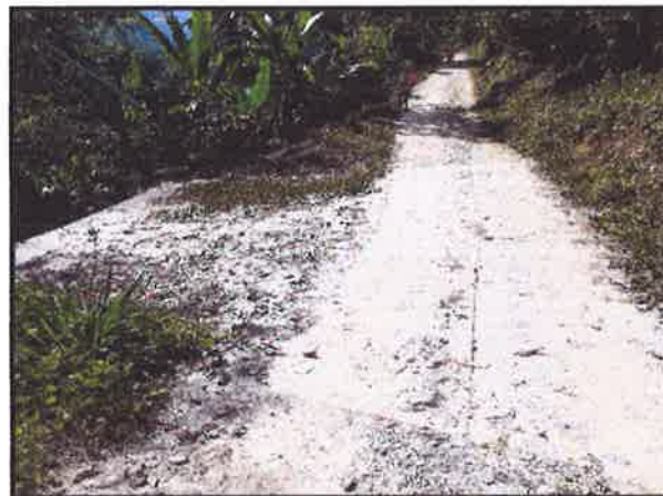
FOTOGRAFIA N°15: SE OBSERVA EL BADEN N°15.PROGR.08+725
