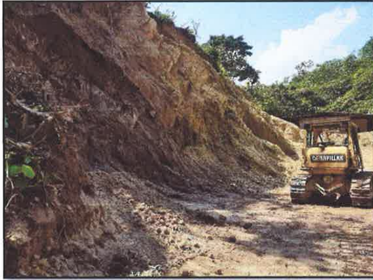
FOTOGRAFIA N°4: SE OBSERVA LA CANTERA (TIPO DE MATERIAL AFIRMADO-COMPACTO).
