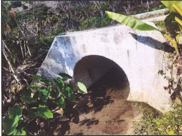
FOTOGRAFIA N°22: SE OBSERVA LA ALCANTARILLA N°7. PROGR.09+070
