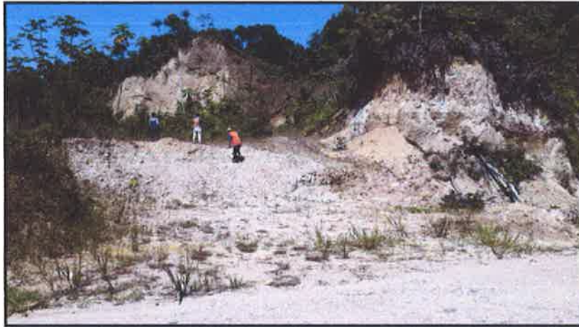
FOTOGRAFIA N°2: SE OBSERVA LA CANTERA (TIPO DE MATERIAL AFIRMADO).
