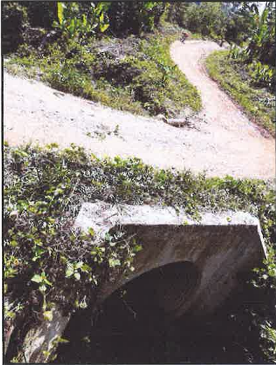
FOTOGRAFIA N°20: SE OBSERVA LA ALCANTARILLA N°5. PROGR.07+266
