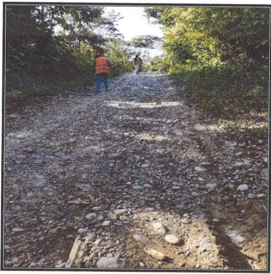
VISTA FOTOGRÁFICA DE LA CALICATA 21, PROGRESIVA 05+250, donde se aprecia la medición del afirmado registrado en campo E= 7.00 cm, además se puede apreciar la invasión de las plantas silvestres por ambos lados de la plataforma, las cunetas que se encuentran cubiertas por material deslizados del talud y plantas silvestres.
