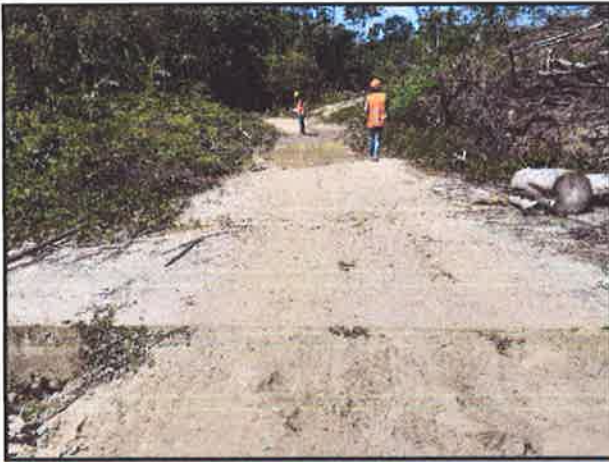
FOTOGRAFIA N°7: SE OBSERVA EL BADEN N°7.PROGR.07+237
