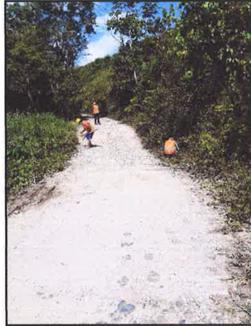
FOTOGRAFIA N°2: SE OBSERVA EL BADEN N°2.PROGR.01+120
