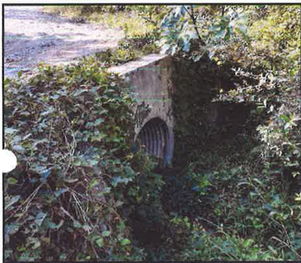
FOTOGRAFIA N°18: SE OBSERVA LA ALCANTARILLA N°3. PROGR.05+304
