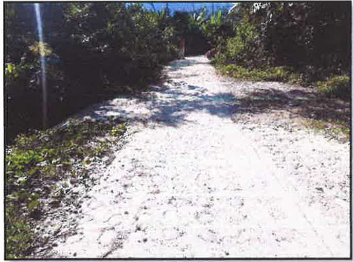
FOTOGRAFIA N°4: SE OBSERVA EL BADEN N°4.PROGR.05+724
