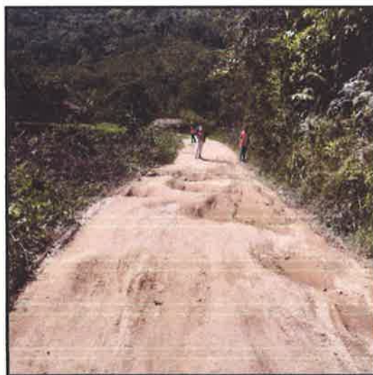
FOTO N° 01 y 02 se puede apreciar el estado de la superficie de rodadura entre el km 00+000 – km 09+591
