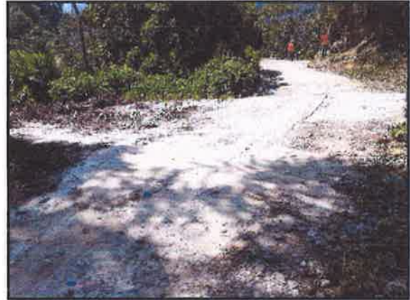
FOTOGRAFIA N°10: SE OBSERVA EL BADEN N°10.PROGR. 08+062
