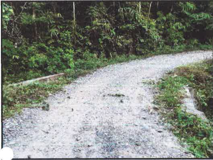
FOTOGRAFIA N°16: SE OBSERVA LA ALCANTARILLA N°1.PROGR. 04+655
