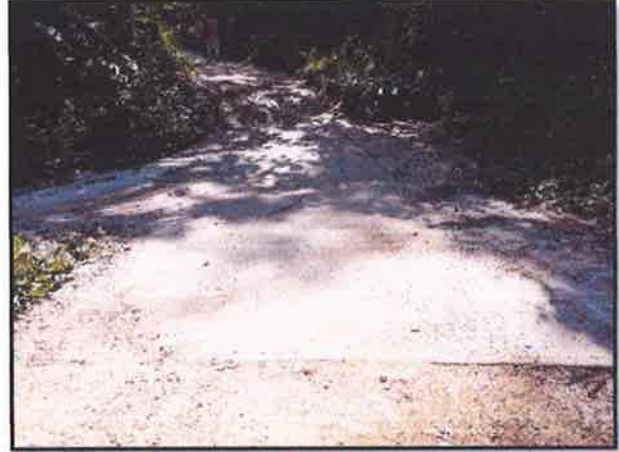
FOTOGRAFIA N°6: SE OBSERVA EL BADEN N°6.PROGR.06+562
