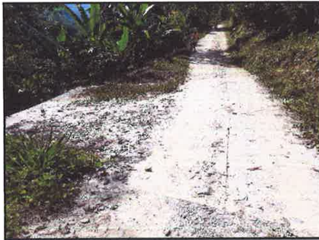
FOTOGRAFIA N°15: SE OBSERVA EL BADEN N°15.PROGR.08+725
