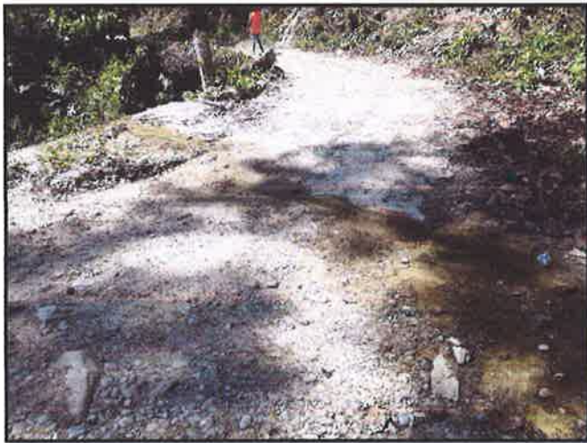
FOTOGRAFIA N°11: SE OBSERVA EL BADEN N°11.PROGR. 08+125
