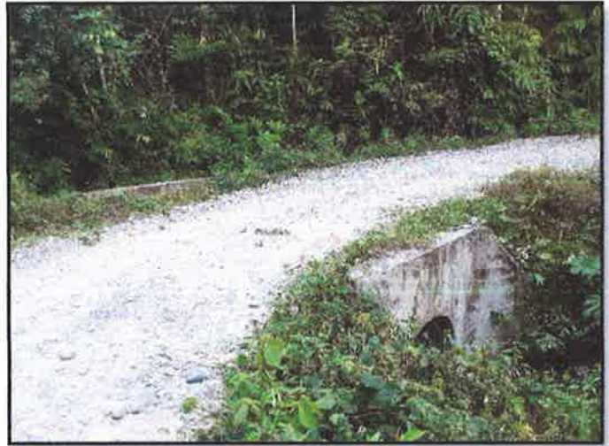
FOTOGRAFIA N°17: SE OBSERVA LA ALCANTARILLA N°2.PROGR.05+028
