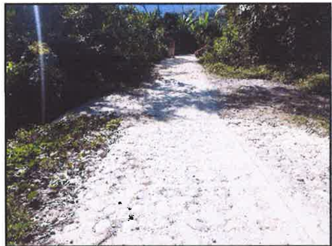
FOTOGRAFIA N°4: SE OBSERVA EL BADEN N°4.PROGR.05+724
