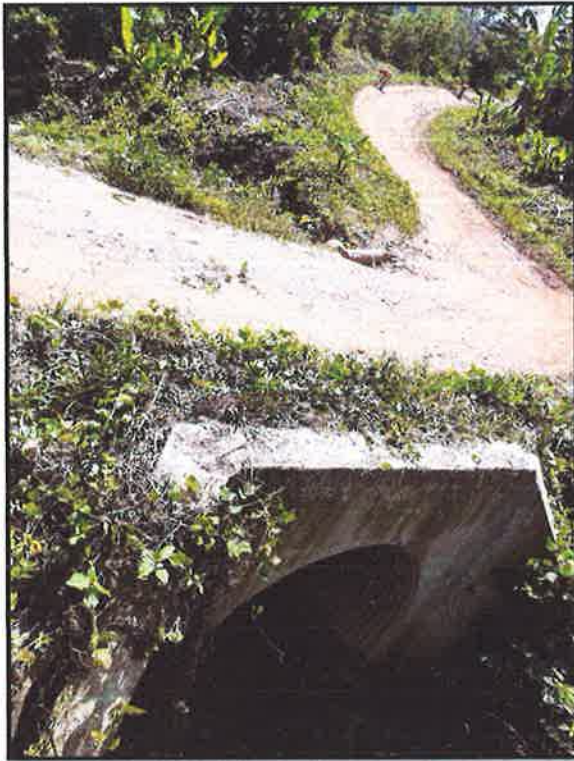
FOTOGRAFIA N°20: SE OBSERVA LA ALCANTARILLA N°5.PROGR.07+266
