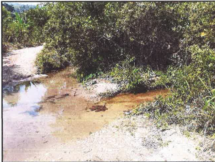
FOTOGRAFIA N°24: SE OBSERVA EL BADEN N°2.PROGR.3+510
