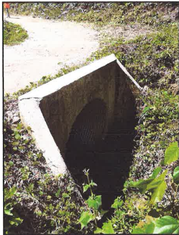
FOTOGRAFIA N°21: SE OBSERVA LA ALCANTARILLA N°6.PROGR. 08+523
