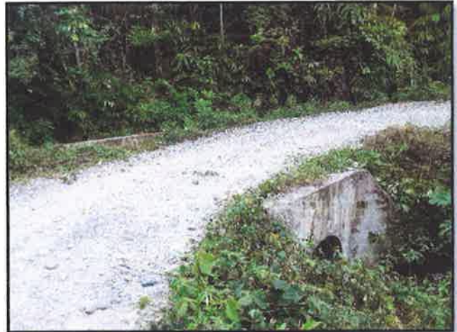
FOTOGRAFIA N°17: SE OBSERVA LA ALCANTARILLA N°2.PROGR.05+028
