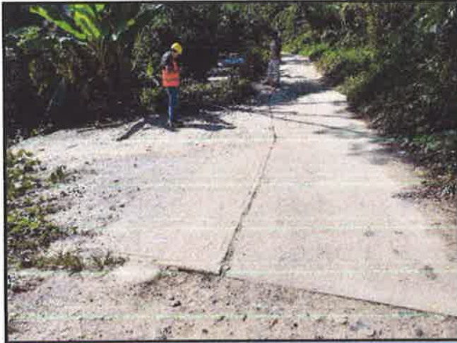
FOTOGRAFIA N°5: SE OBSERVA EL BADEN N°5.PROGR.06+194
