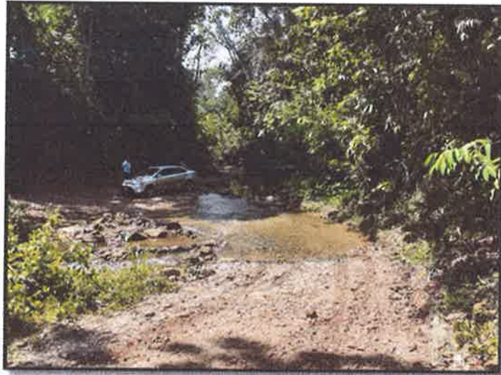
Fotografía N° 03, tramo II, fuente de agua de quebrada con caudal medio para riego en afirmado, ubicado en a 00+140 km. con acceso directo de la carretera, el cual se encuentra en libre disponibilidad.
