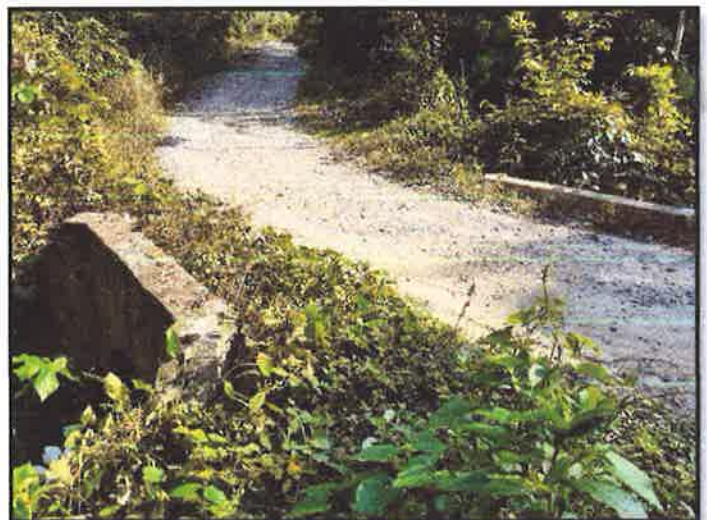
FOTOGRAFIA N°19: SE OBSERVA LA ALCANTARILLA N°4.PROGR.05+407
