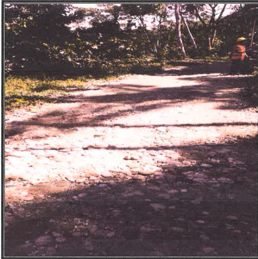
VISTA FOTOGRÁFICA DE LA CALICATA 04, PROGRESIVA 00+750, donde se aprecia la medición del afirmado registrado en campo E= 0.00 cm, además se puede apreciar la invasión de las plantas silvestres por ambos lados de la plataforma, las cunetas que se encuentran cubiertas por material deslizados del talud y plantas silvestres.
