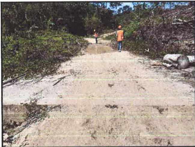
FOTOGRAFIA N°7: SE OBSERVA EL BADEN N°7.PROGR.07+237
