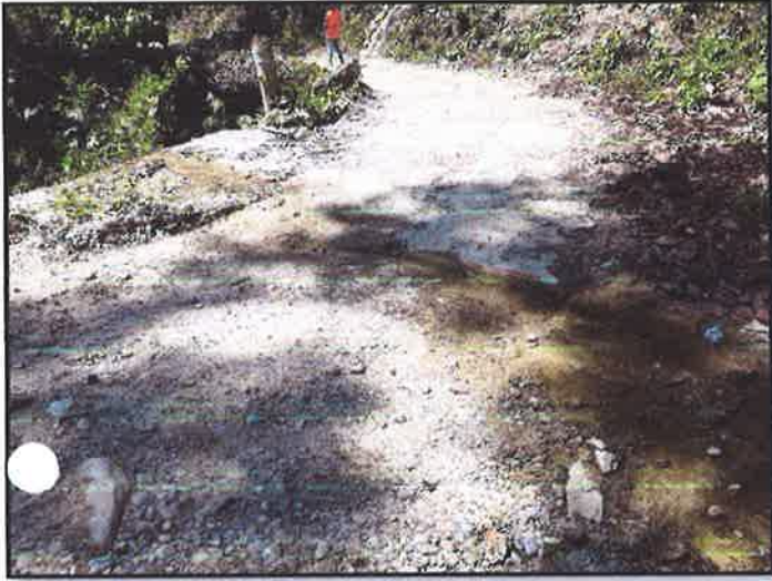
FOTOGRAFIA N°11: SE OBSERVA EL BADEN N°11.PROGR. 08+125
