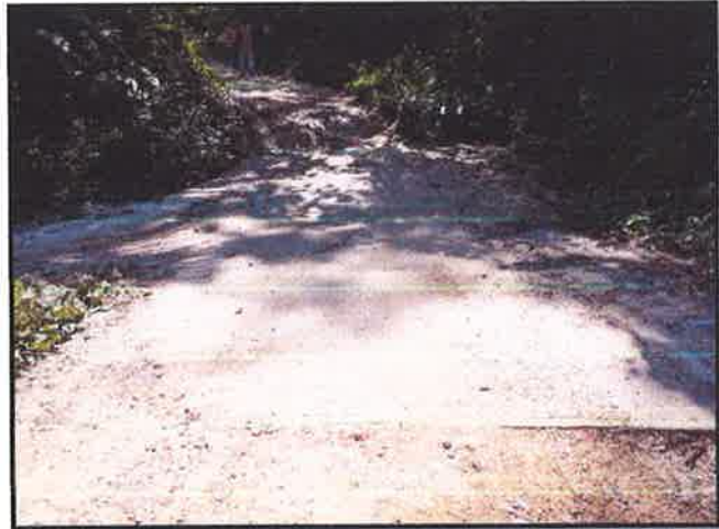
FOTOGRAFIA N°6: SE OBSERVA EL BADEN N°6.PROGR.06+562
