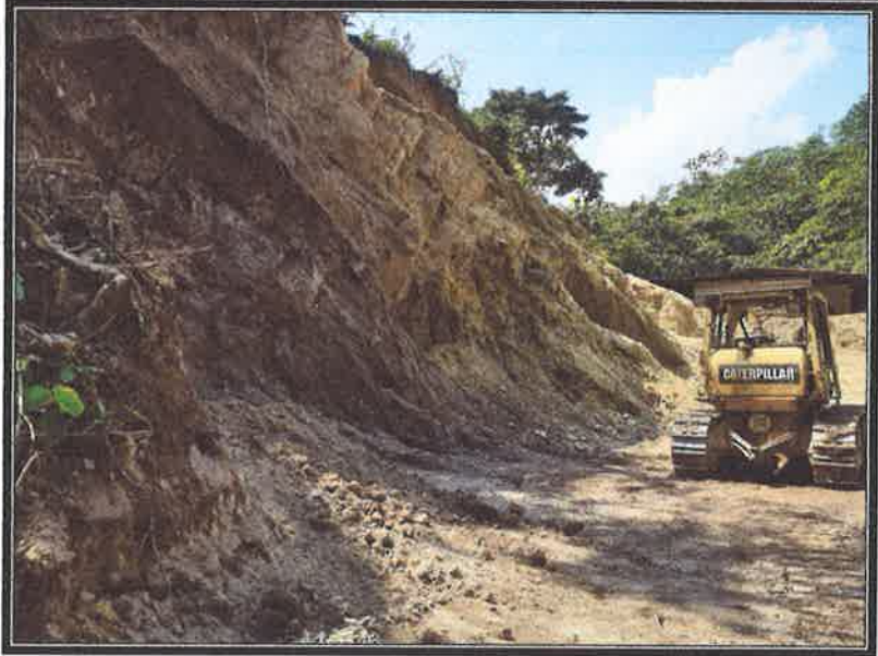
Vista fotográfica de la cantera Tramo II- en la ubicada en la prog. 00+220 al lado izquierda con acceso directo, donde se aprecia la cantera conformada por grava limo arcillosa.
