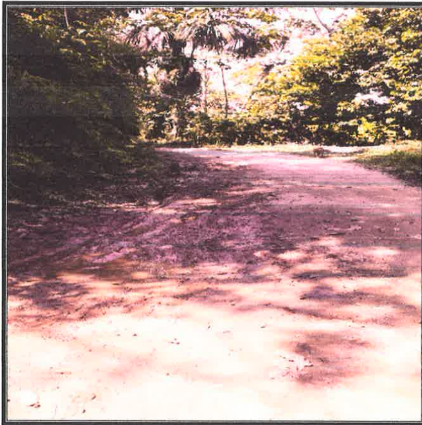
VISTA FOTOGRÁFICA DE LA CALICATA 03, PROGRESIVA 00+500, donde se aprecia la medición del afirmado registrado en campo E= 4.00 cm, además se puede apreciar la invasión de las plantas silvestres por ambos lados de la plataforma, las cunetas que se encuentran cubiertas por material deslizados del talud y plantas silvestres.
