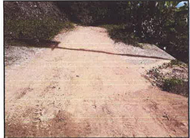
FOTOGRAFIA N°8: SE OBSERVA EL BADEN N°8.PROGR.07+571
