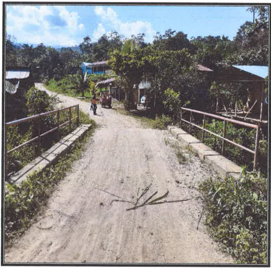
VISTA FOTOGRÁFICA DE LA CALICATA 25, PROGRESIVA 06+000, donde se aprecia la medición del afirmado registrado en campo E= 4.00 cm, además se puede apreciar la invasión de las plantas silvestres por ambos lados de la plataforma, las cunetas que se encuentran cubiertas por material deslizados del talud y plantas silvestres, además existen derrumbes de los taludes que contaminan el afirmado de la plataforma de rodadura.
