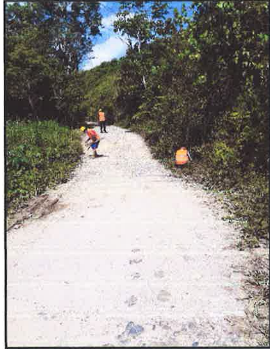
FOTOGRAFIA N°2: SE OBSERVA EL BADEN N°2.PROGR.01+120
