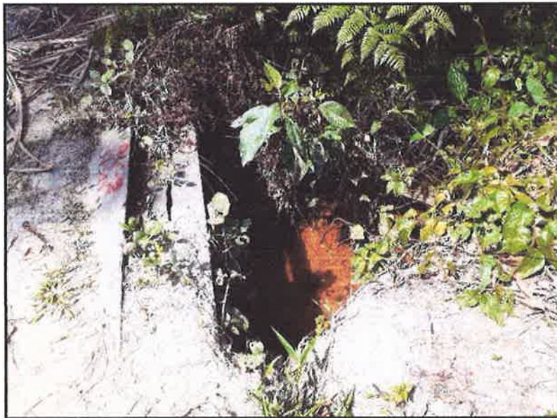
FOTOGRAFIA N°26: SE OBSERVA LA ALCANTARILLA N°2. PROGR.3+394
