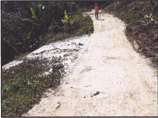
FOTOGRAFIA N°13: SE OBSERVA EL BADEN N°13.PROGR.08+581
