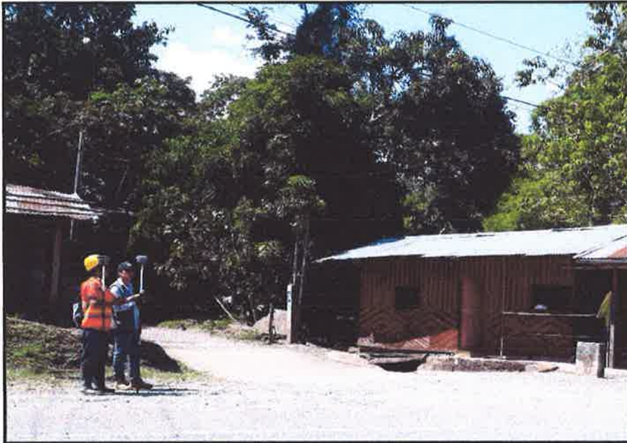
FOTOGRAFIA N°23: SE OBSERVA EL BADEN N°1.PROGR.00+010
