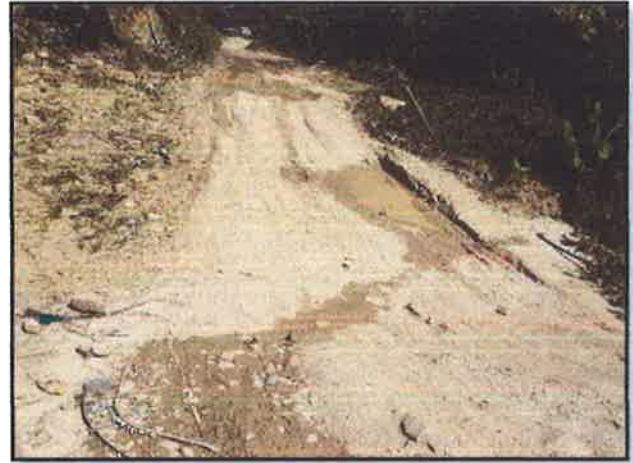
FOTOGRAFIA N°14: SE OBSERVA EL BADEN N°14.PROGR. 08+624
