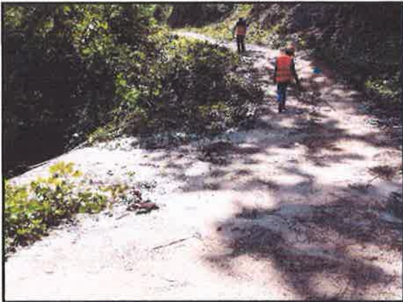
FOTOGRAFIA N°9: SE OBSERVA EL BADEN N°9.PROGR.07+660
