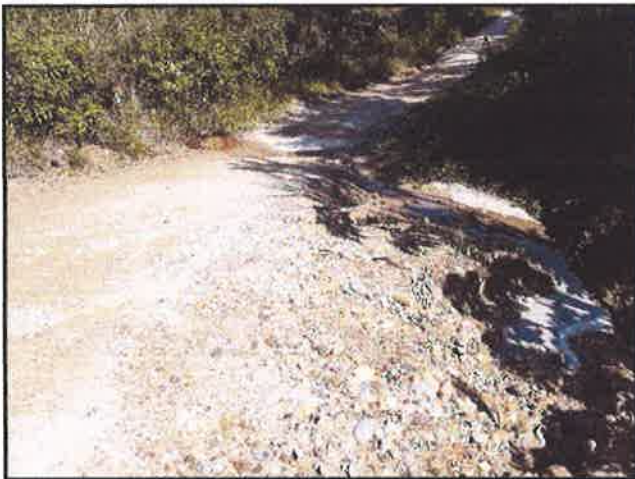
FOTOGRAFIA N°3: SE OBSERVA EL BADEN N°3.PROGR.05+589
