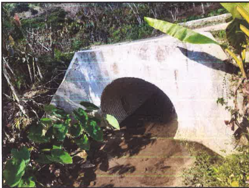
FOTOGRAFIA N°22: SE OBSERVA LA ALCANTARILLA N°7.PROGR.09+070
