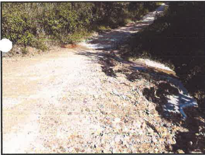
FOTOGRAFIA N°3: SE OBSERVA EL BADEN N°3.PROGR.05+589
