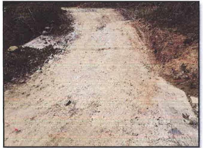
FOTOGRAFIA N°12: SE OBSERVA EL BADEN N°12.PROGR.08+234
