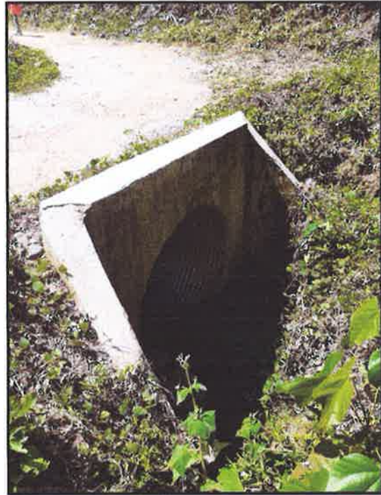
FOTOGRAFIA N°21: SE OBSERVA LA ALCANTARILLA N°6. PROGR. 08+523
