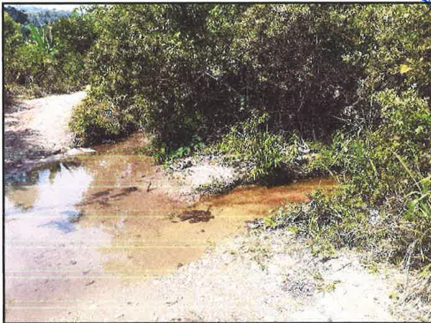
FOTOGRAFIA N°24: SE OBSERVA EL BADEN N°2.PROGR.3+510
