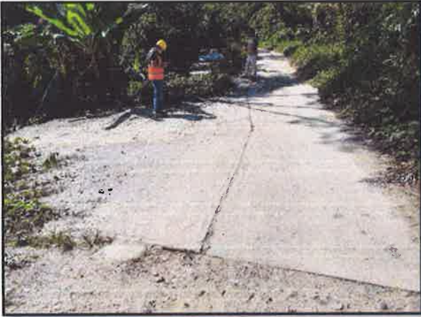
FOTOGRAFIA N°5: SE OBSERVA EL BADEN N°5.PROGR.06+194
