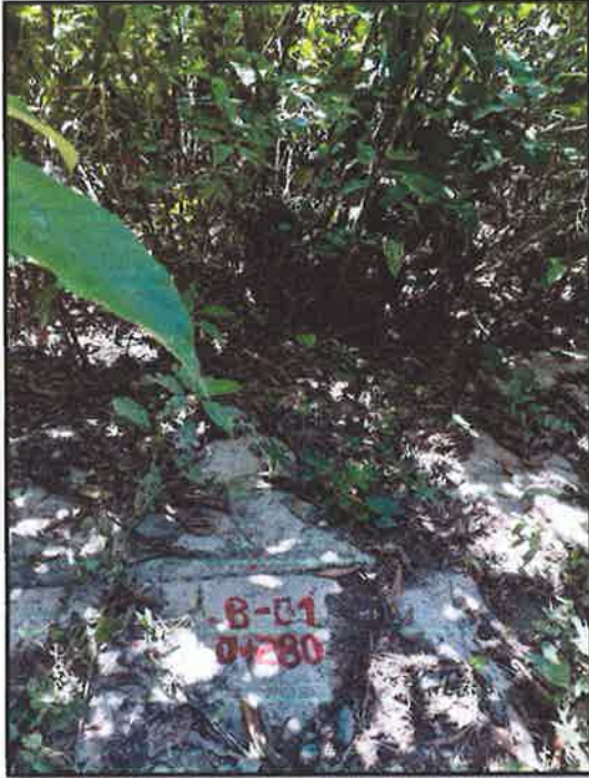
FOTOGRAFIA N°1: SE OBSERVA EL BADEN N°1.PROGR.00+280
