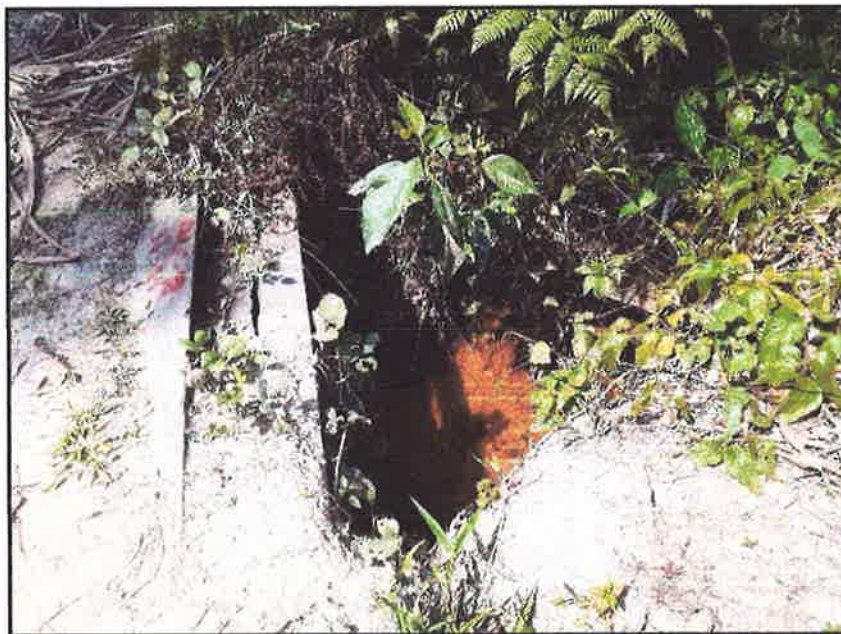
FOTOGRAFIA N°26: SE OBSERVA LA ALCANTARILLA N°2. PROGR.3+394
