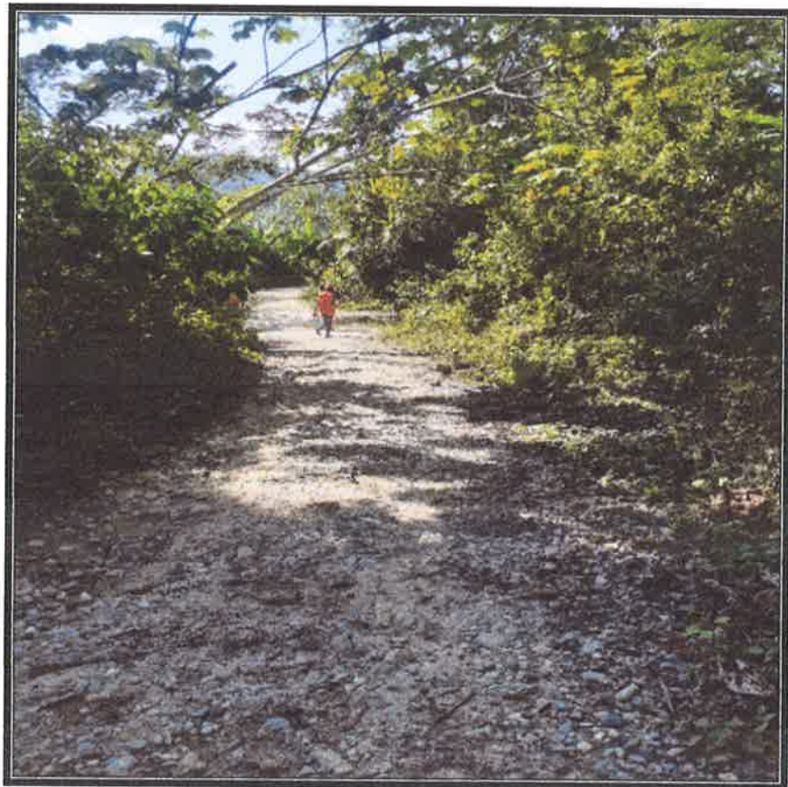
VISTA FOTOGRÁFICA DE LA CALICATA 24, PROGRESIVA 05+750, donde se aprecia la medición del afirmado registrado en campo E= 5.00 cm, además se puede apreciar la invasión de las plantas silvestres por ambos lados de la plataforma, las cunetas que se encuentran cubiertas por material deslizados del talud y plantas silvestres.
