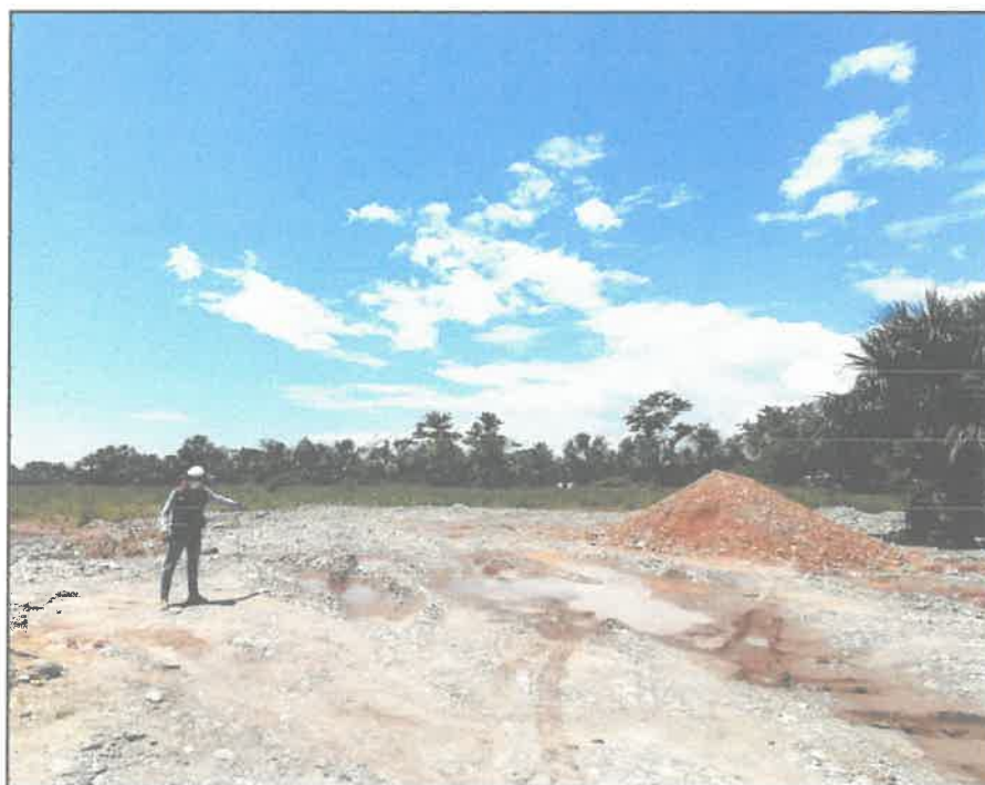
FOTOGRAFIA N° 02: Se puede apreciar en la imagen la recuperación de áreas ocupadas como centro de material seleccionado de afirmado para el mantenimiento rutinario.
