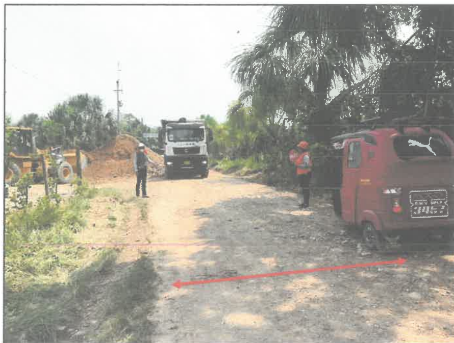
FOTOGRAFIA N° 01: Se puede apreciar en la imagen la restricción de vehículos temporalmente para evitar posibles accidentes en el desplazamiento de los vehículos pesados.
