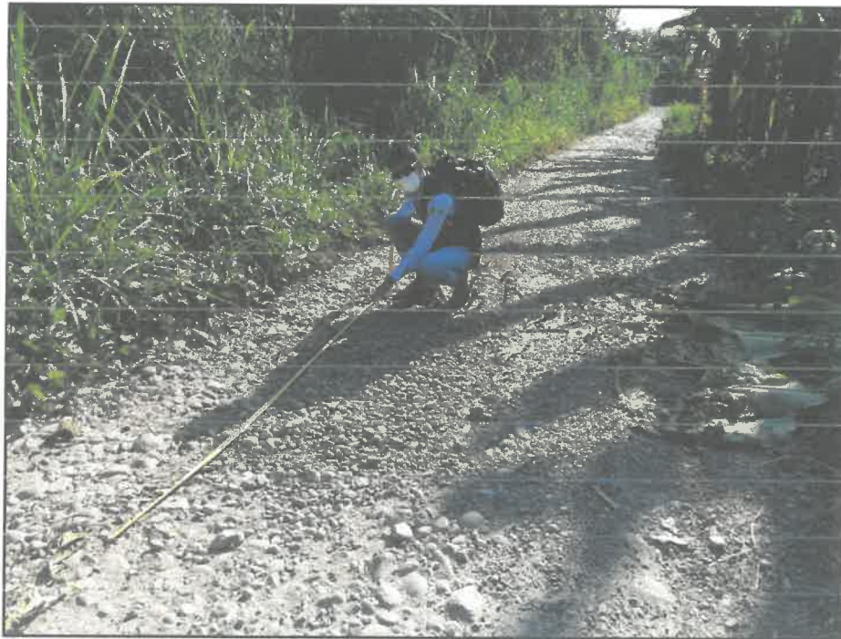
FOTOGRAFÍA N° 23: CODIGO SSR07: Se observa el tramo N° 02 Shiringal – CPT, entre las progresivas 2+150.00 - 2+170.00, que se presentan daños en la superficie de rodadura de tipología Baches.
