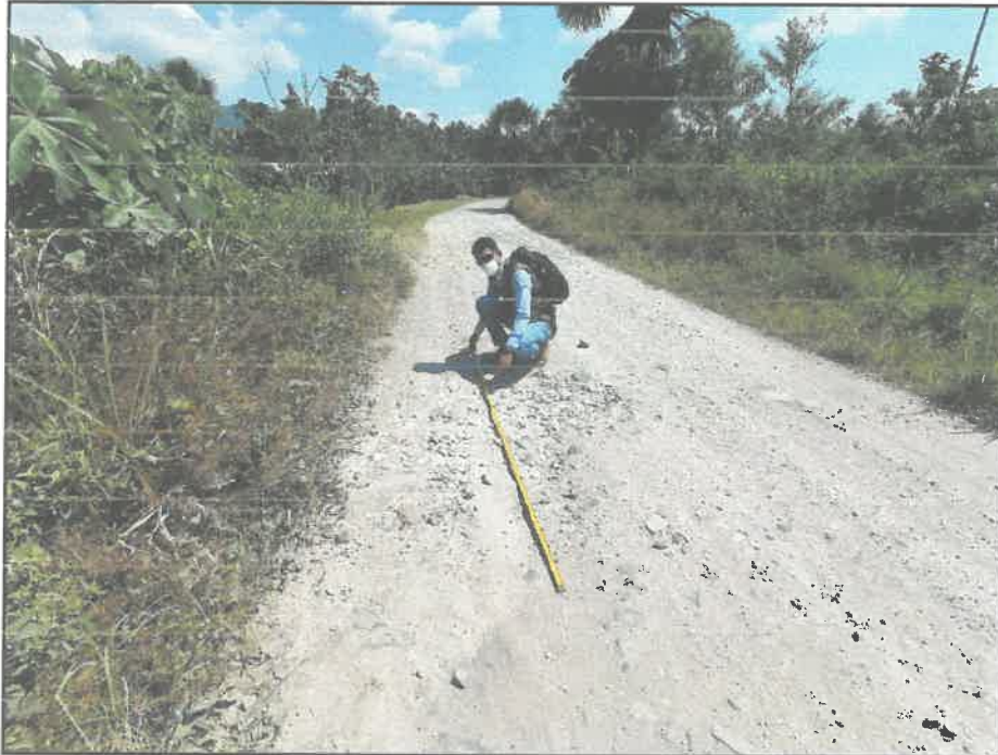
FOTOGRAFÍA N° 09: CODIGO VSR09: Se observa el tramo N° 01 Venenillo-Corvina, entre las progresivas 4+190.00 - 4+210.00, que se presentan daños en la superficie de rodadura de tipología Baches.
