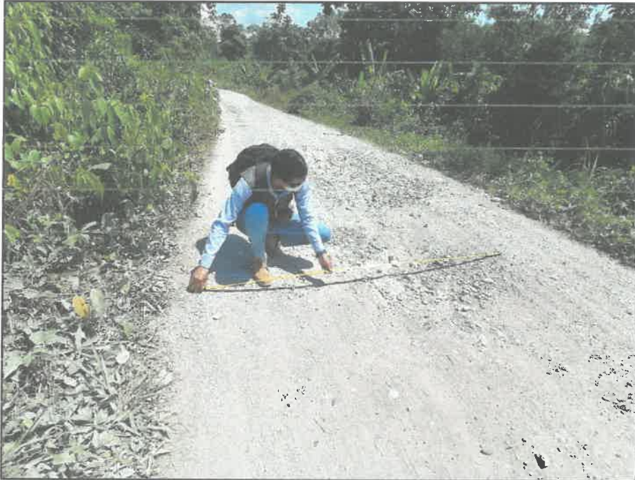
FOTOGRAFÍA N° 05: CODIGO VSR05: Se observa el tramo N° 01 Venenillo – Corvina, entre las progresivas 1+690.00 - 1+710.00, que se presentan daños en la superficie de rodadura de tipología Baches.
